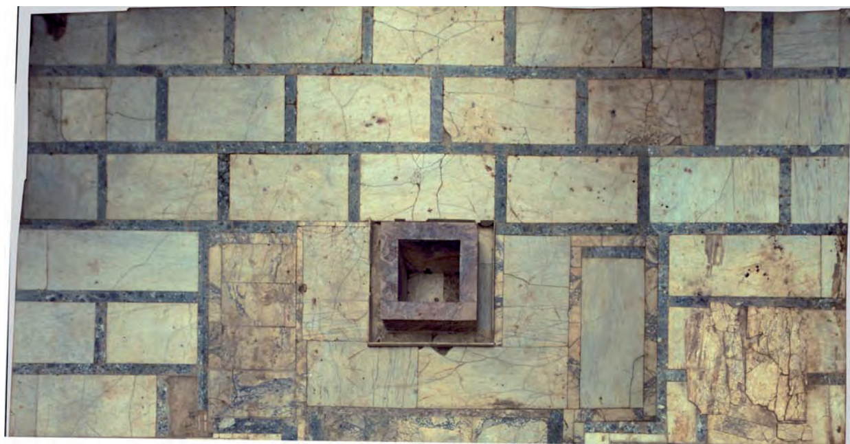
Abb. 2: Marmorsaal 31, Bodenbelag im N-Teil des Raumes
