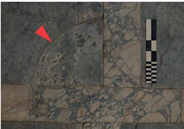
Abb. 37: OG-Raum 32, Bodendetail Ausflickung (Viertelkreis)
