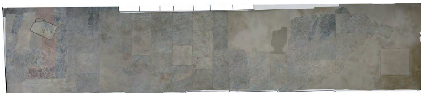
Abb. 3: Nordportikus 31aN, Boden
